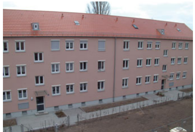
Nach EnEV fertig gestellter 1. Umbauabschnitt
