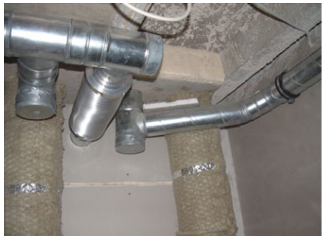
Montage der Lüftungskanäle in den Wohnungen
