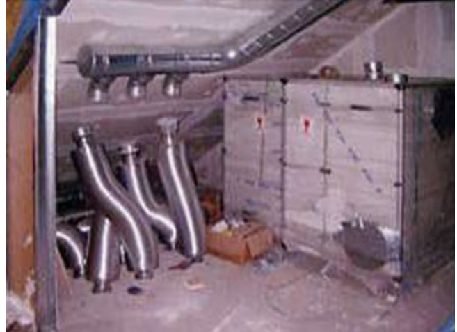
Montage der Lüftungszentrale
