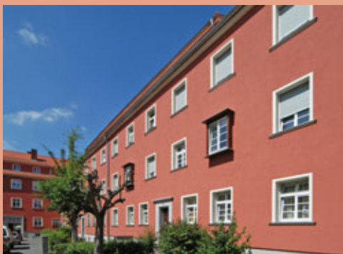
Energetische Modernisierung, Wohnanlage St. Johannis, 7-Liter-Standard
