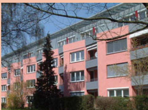
„Das Niedrigenergiehaus der wbg“, Bernadottestraße 42-48
