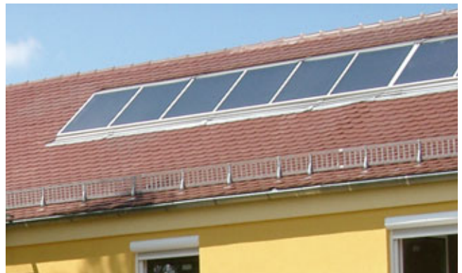
Solarthermische Anlage
