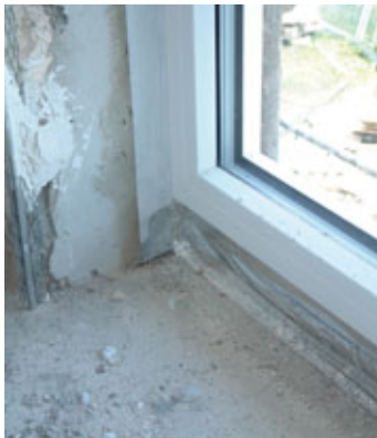
Folienabklebung der Fenster-/wandanschlüsse zur Gewährleistung der Winddichtigkeit
