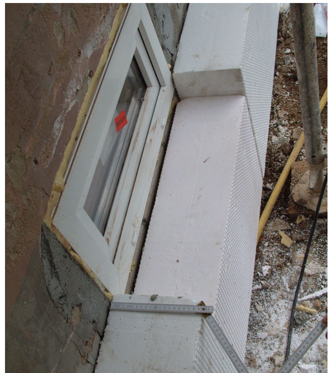
Wärmedämmverbundsystem 20 cm Neopor
