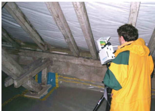
Thermografie der Dachboden-Luftdichtung
