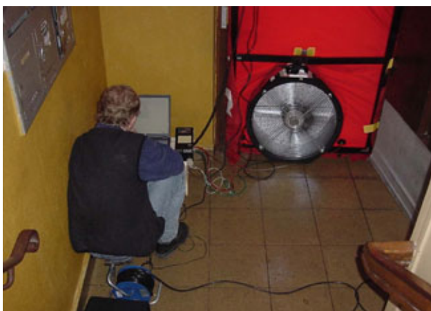
Blower-Door-Messung – n50 vorher 4,9 h-1 nachher 0,35 h-1
