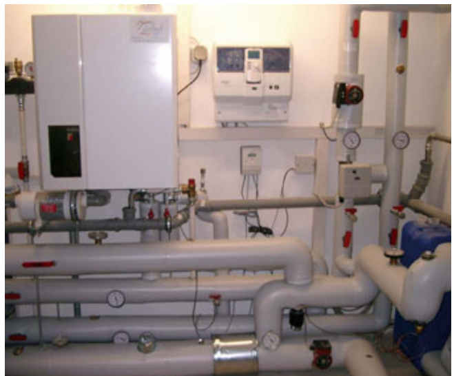
Kunst am Bau: Dämmung der Leitungen im Heizraum
