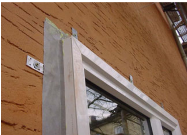
Luftdichtung der Fenster außenwandbündig
