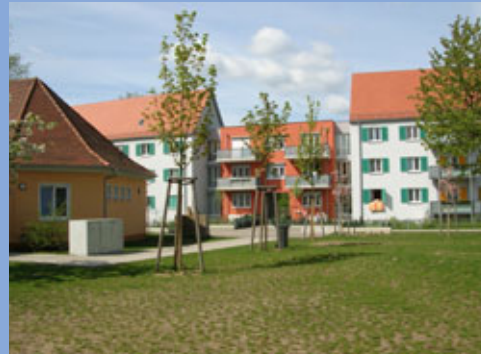
Ökologische Bestandsmodernisierung, Wohnanlage Schweinau, 5-Liter-Standard
