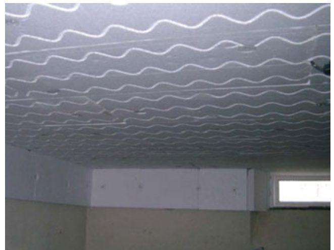
Dämmung der KG-Decke und Wärmebrückenreduktion an den Wänden
