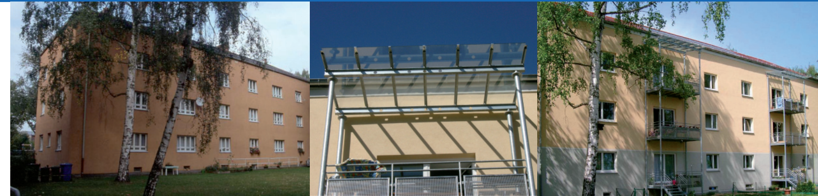
WBG Nürnberg Gruppe: Modernisierung Jean-Paul-Platz 4 (3 Liter-Standard WSVO) Gesamtkosten: 623.000,00 EUR, reine Baukosten je m 2 Wohnfläche: 503,00 EUR, enthaltene Mehrkosten für Passivhaus-Komponenten je m 2 : ca. 100,00 EUR
