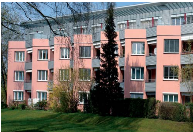
Ansicht von Südwest nach der Sanierung
