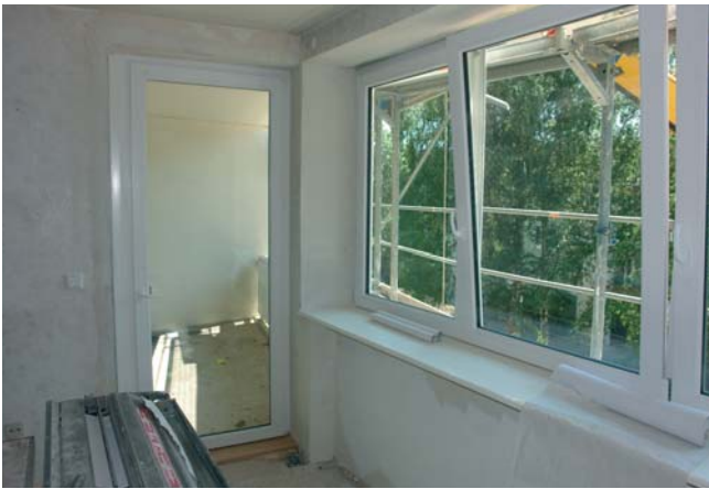
Neue Fenster im Wohnzimmer mit Dreischiebenwärmeschutzverglasung
