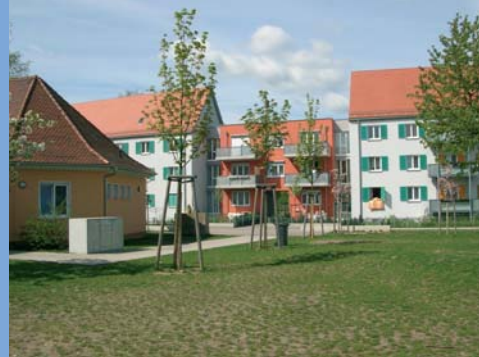
Ökologische Bestandsmodernisierung, Wohnanlage Schweinau, 5-Liter-Standard
