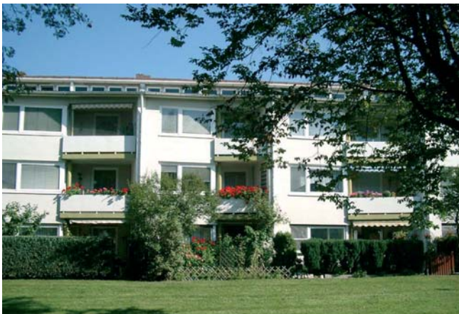
Ansicht von Südwest vor der Sanierung
