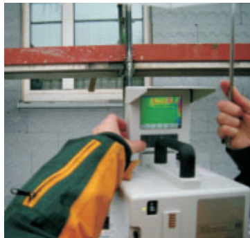
Baubegleitende Qualitätssicherung mittels Infrarot-Thermografie.
