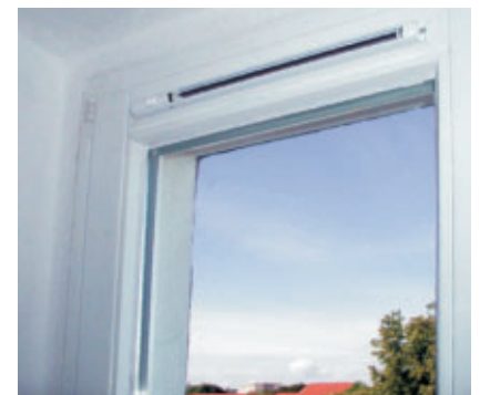
Außenluftdurchlass für Fenstereinbau.
