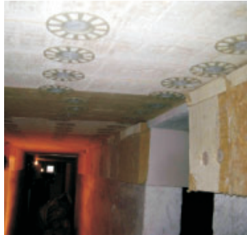
Dämmung der KG-Decke mit Mineralfaserdämmung 20 cm dick.
