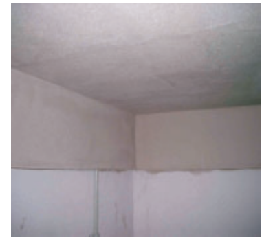
Fertige Spachtelung der Konstruktion oben.
