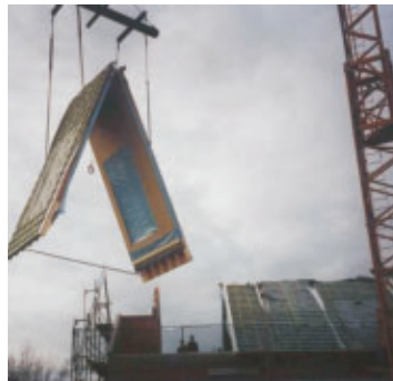
Einsatz von vorgefertigten Vakuumdämmelementen.
