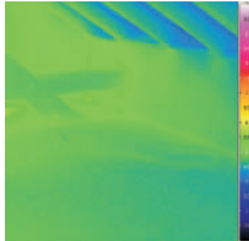
Infrarot-Thermografie der Konstruktion links nach Fertigstellung (Quelle: PHI).
