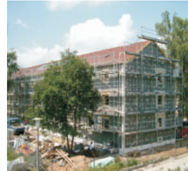
Dämmung 20 cm WLG 035 gedübelt und z. T. verspachtelt (Ingolstädter Straße, Nürnberg).
