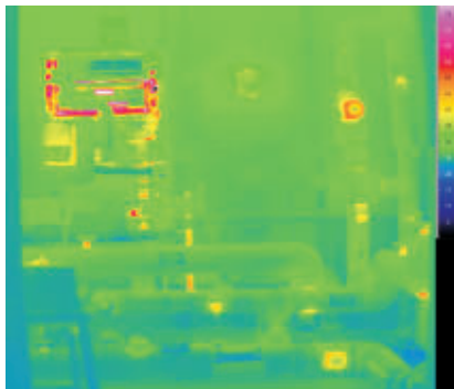
Gas-Brennwert-Anlage als Infrarot-Thermografie.
