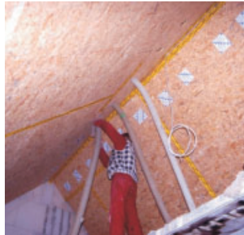
Schrägdach-Dämmung mit Zellulose-Einblasdämmung.
