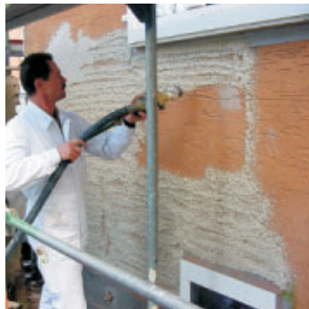
Luftdichtung in der Kleber-Ebene des WDVS bei Sanierung im bewohnten Zustand.
