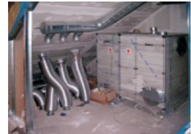
Lüftungszentrale im Bauzustand.
