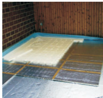
Vakuump-Wärmedämmung mit minimaler Aufbauhöhe (Quelle: Variotec).
