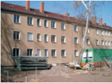
Ingolstädter Straße vor Sanierung.
