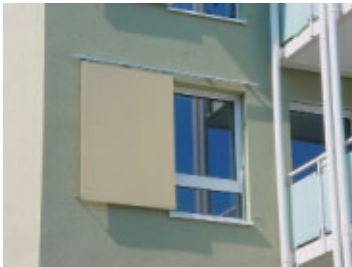
Fenster mit Schiebeladen.
