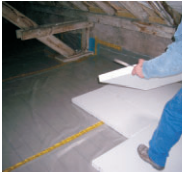
Luftdichtung, 25 cm Dämmung und Estrich auf der obersten Geschossdecke.
