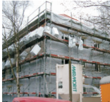
Wärmedämmplatten 20 cm dick zum größten Teil verklebt (Jean-Paul-Platz 4, Nürnberg).
