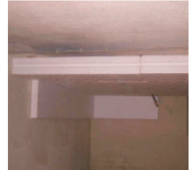
Kellerdeckendämmung mit 14 cm Polystyrol.
