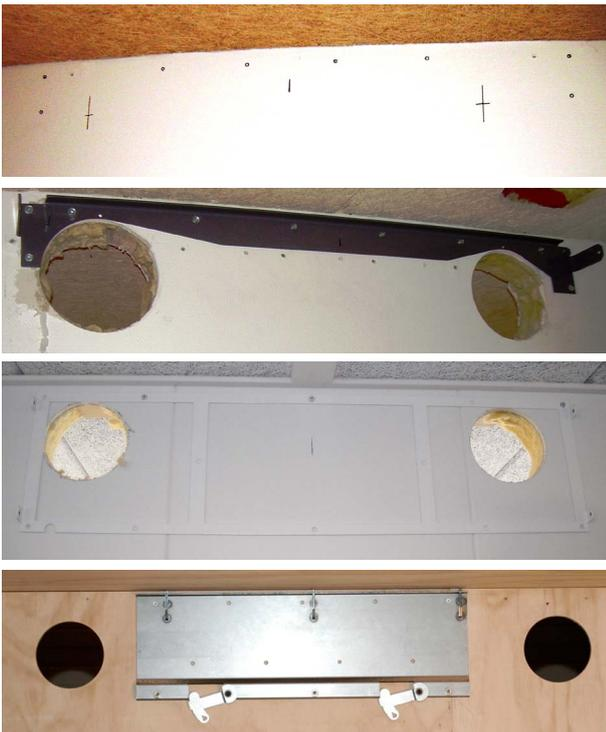
Das Bohren der Löcher, die Lochgrößen und Montagematerialien hängen von Wandmaterial und Gerät ab.
