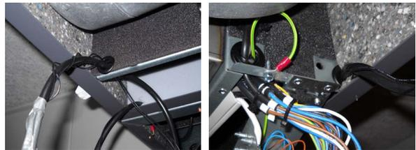
Bei einem Lüftungsgerät 180 muss die Hauptbox zum Anschließen der Leitungen gelöst (1 Schraube an der Kabeldurchführung) und heruntergeklappt werden.
