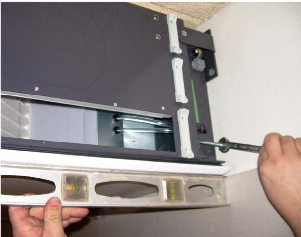
Am Boden von Gerät/Kühlmodul sind an beiden Seiten Einstellschrauben (nicht bei allen Modellen).
