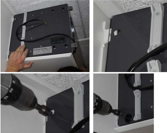
3. Gerät/Kühlmodul in waagerechte Position bringen (nur 100 und 300).
