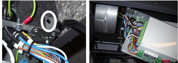
Bei den Lüftungsgeräten 180, 500 und 800 muss das Datenkabel zum Bedienpaneel, das innen in dem Gerät liegt, durch die Kabeldurchführungen aus dem Gerät herausgeführt werden.
