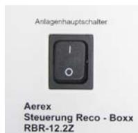
Bei Betätigung des Anlagenhauptschalters wird die gesamte Anlage allpolig vom Netz getrennt.
