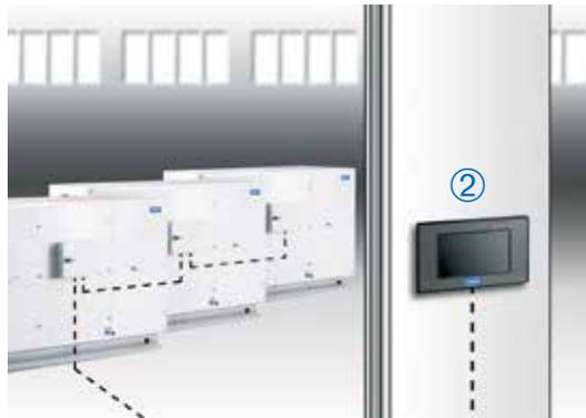
③ **Netzwerklösung über Gebäudeleittechnik:** Steuern und überwachen Sie Ihre Geräte mittels Gebäudeleittechnik, das MODBUS-RTU-Protokoll ermöglicht als Basic-Protokoll die Anbindung an quasi alle GLT-Systeme, moderne Converter ermöglichen dies. Als Schnittstelle ist das Interface SAT-MODBUS je Gerät notwendig. Für den Einsatz in einem KNX-System ist das SAT-KNX erhältlich.
