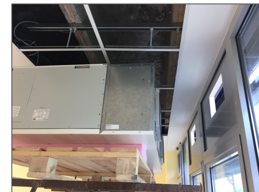
11. Gerät (inkl. dem montierten Anschlusskasten) an die beiden vorgesehenen Ausschnitte an der Fassade anbringen und das Fassadenelement mit dem Rahmen verschrauben. Die aufgetragenen Dichtstreifen stellen eine dichte Verbindung zwischen Fassadenelement und Rahmen her.
