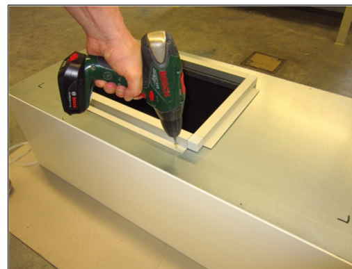
10. Anschlusskasten mit den 4 mitgelieferten Schrauben M8 x 25 mm fest mit dem Gerät verschrauben.
